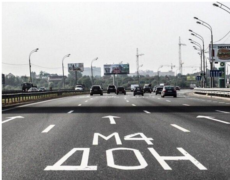
Рисунок 1 – Участок автомобильной дороги М-4 «Дон»
